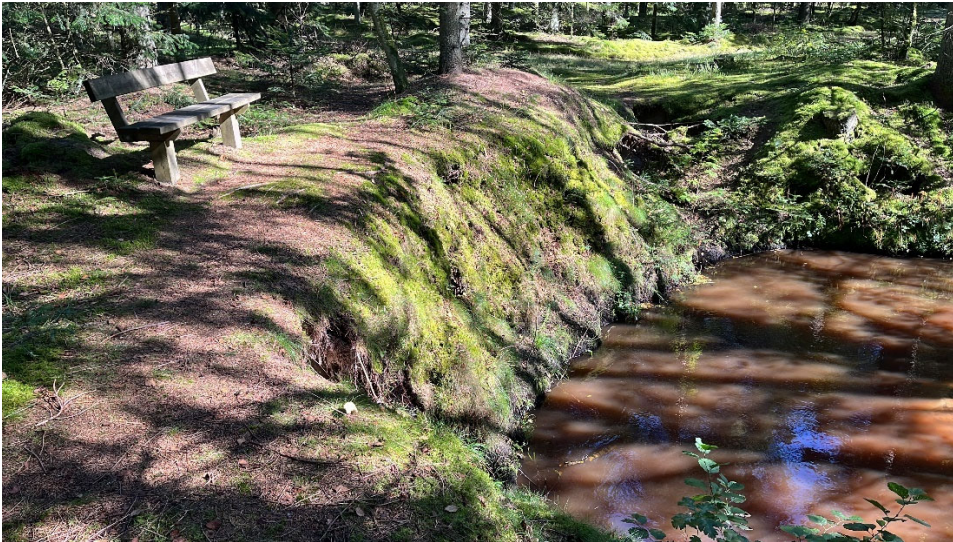
Billede af strækningen omkring station 3.282 hvor der skal erosionssikres.
